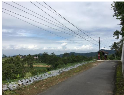
Gambar 5. Realisasi pembangunan jalan penghubung Dusun Ngudal dan Dukuh Bomo
