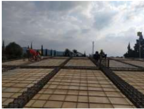
Gambar 4.29 : Plat Lantai Beton
