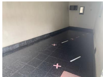
Gambar 3.15 Keadaan Shaf Mushola Bagian Utara
