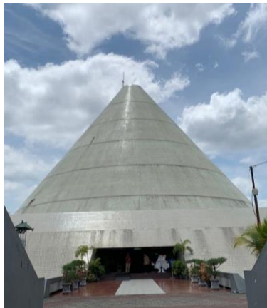
Gambar 3.5 Gedung Utama MONJALI
