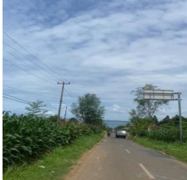
Gambar 4.6 Akses jalan menuju POB Bukit Gelumpai 9
