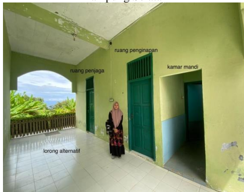
Gambar 3.7 Lorong alternatif, ruang penjaga, ruang penginapan dan kamar mandi POB Bukit Gelumpai Lampung Selatan
