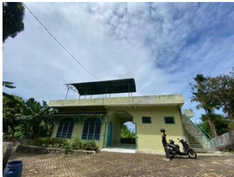
Gambar 3.5 Tampilan depan gedung POB Bukit Gelumpai Lampung Selatan 20
