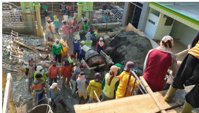
Gambar 3. 2 Gotong Royong Pengecoran Tempat Ibadah
