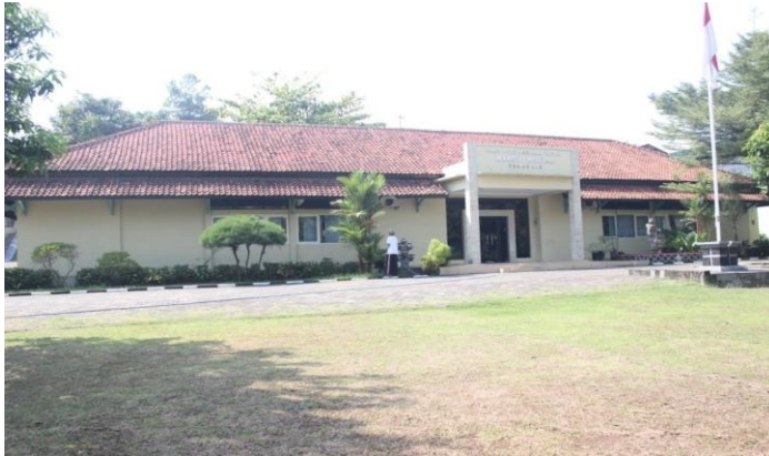
Gambar 16, Foto Gedung Kantor
