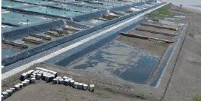
Gambar 8. IPAL yang ada di BUBK
