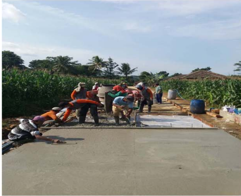
Proses Gotong Royong Pembuatan Betonisasi Jalan Desa Kaligading
