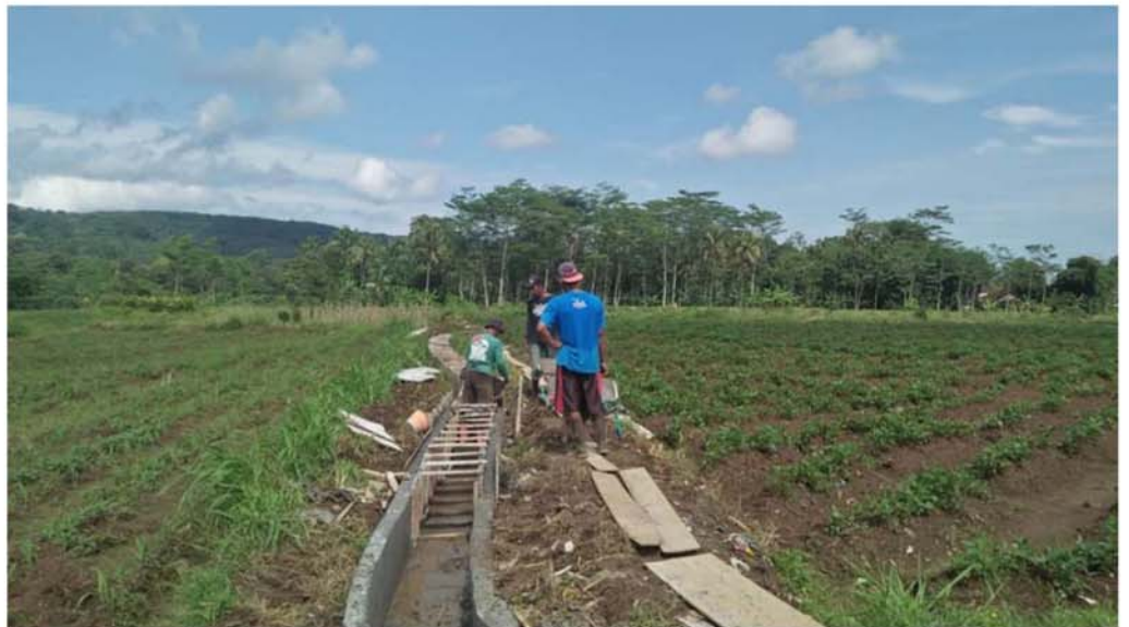
Proses Pembangunan Talut Desa Kaligading
