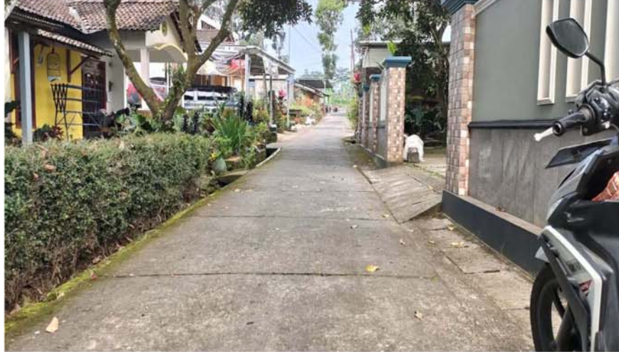
Pembangunan Jalan Infrastruktur Desa Kaligading
