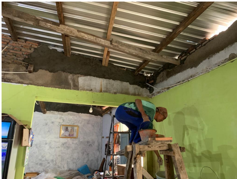
Renovasi ruang untuk peziarah
