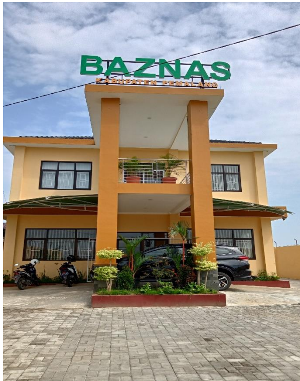
Kantor BAZNAS Kabupaten Pemalang yang Baru
