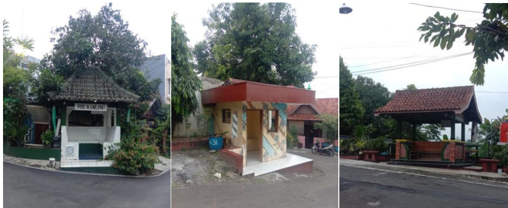
Poskamling sarana keamanan di Perumahan BPI
