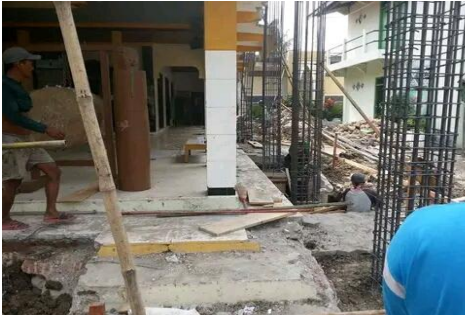
(Pembangunan Masjid Suada')
