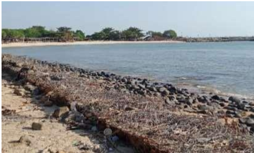
Gambar 4. Kondisi Pemecah Ombak di Pantai Empurancak
