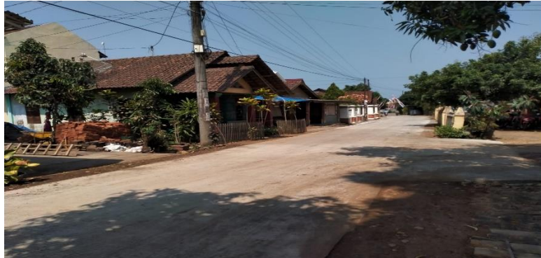
Gambar 1. 14 Kondisi Jalan Setelah di Perbaiki
