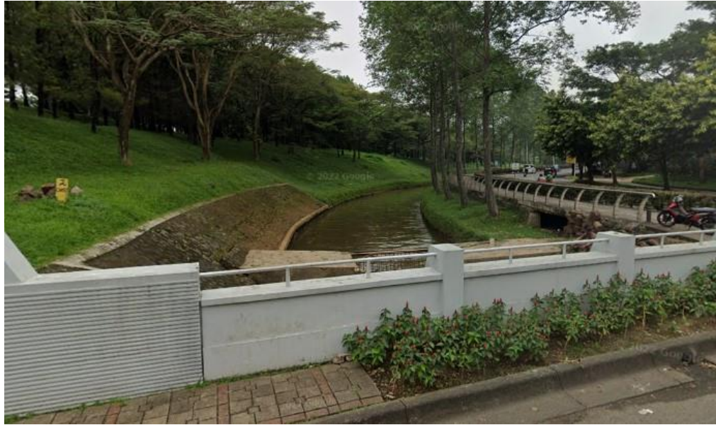
gambar 18 Drainase di Bintaro Jaya (Sumber: Dokumentasi Pribadi)
