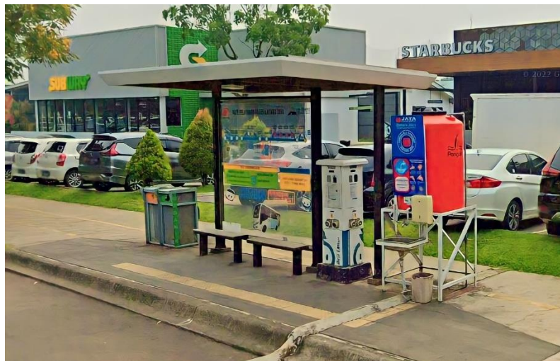
gambar 4 SPLU di Halte Bus Trans Bintaro (sumber: Dokumentasi Pribadi)
