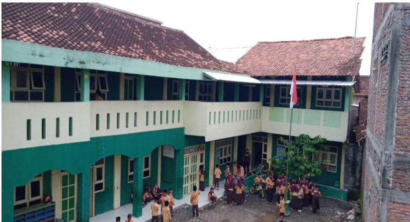
Gedung MI Ibrohimiyyah Mranggen
