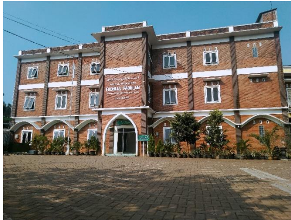
Gambar 4. Gedung asrama pondok putri
