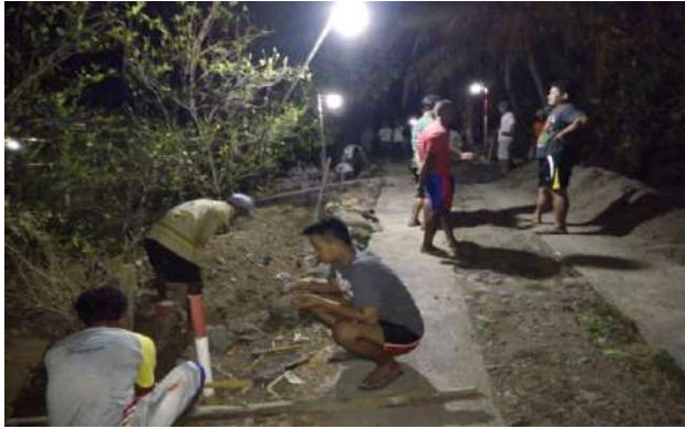
Gambar 1.5 gotong royong pengecoran jalan.
