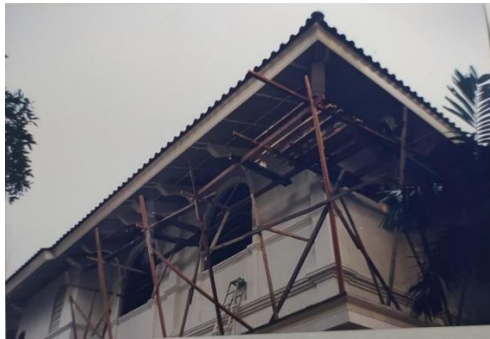
Gambar 3. 3 Penyelesaian Pembangunan Masjid Pangeran Kuningan Tahun 1999
