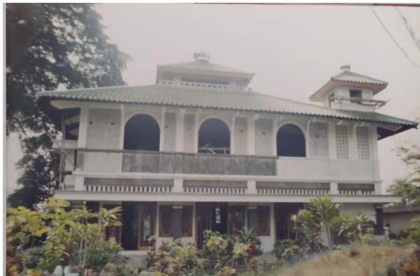
Gambar 3.7 Bentuk Atap dan Menara Pendek Masjid Pangeran Kuningan
