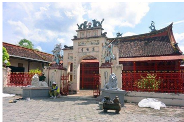
Gambar 2.3 Atap Klenteng Cu An Kiong
