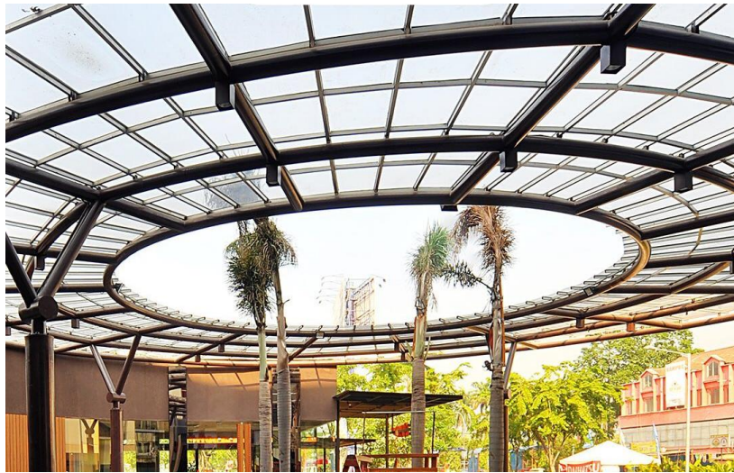
Gambar. 38 Contoh Konsep Struktur Atap Green House
