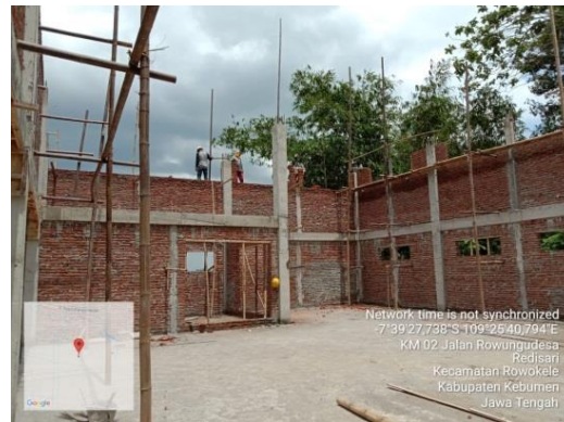
Gambar Contoh Bentangan Kolom Dan Balok Sumber : Dokumentasi Pribadi
