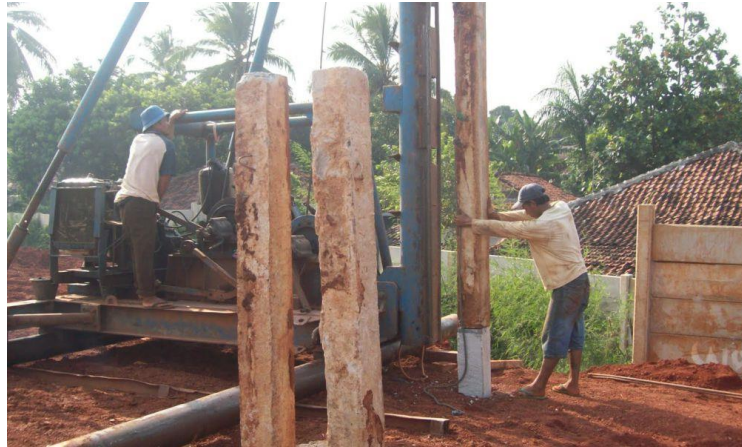
Gambar 4. 26 Pengerjaan Pondasi Strauss Pile
