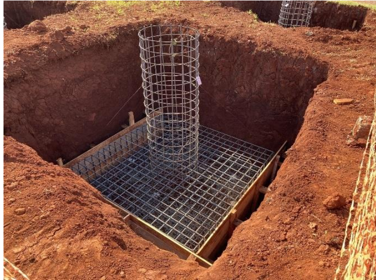
Gambar 4. 25 Pondasi Foot Plat
