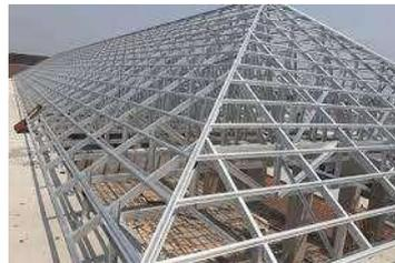
Gambar.11 Kerangka baja ringan
