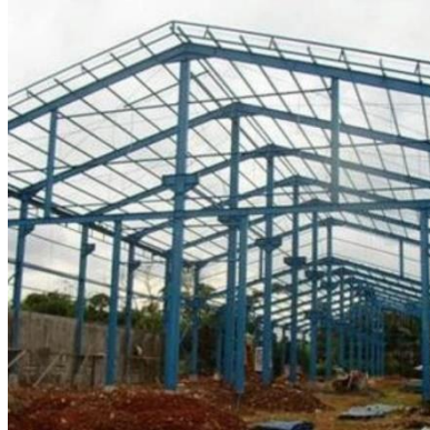
Gambar 4.22 Limasan Baja Wf Sumber: google
