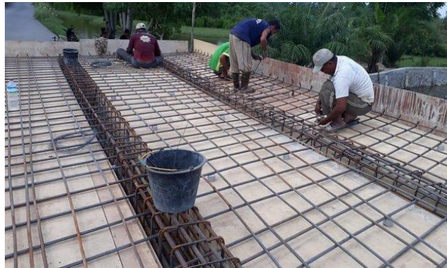
Gambar 4.20 Plat Lantai Beton Sumber: google
