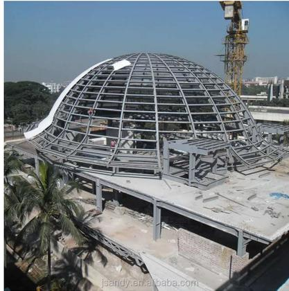
Gambar 4. 17 Struktur atap dome
