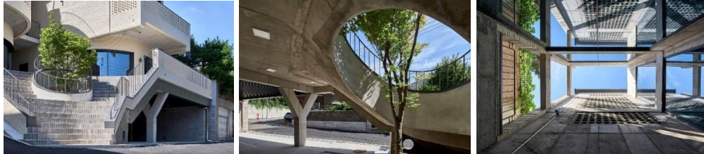
Gambar 2. 15 Area Eksternal Bangunan Y2
