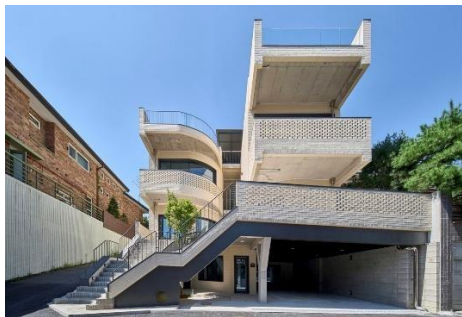
Gambar 2. 14 Fasad bangunan Y2
