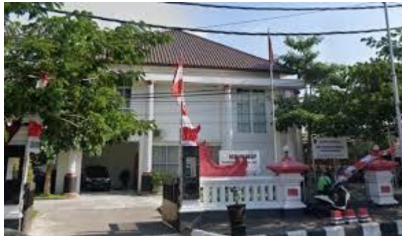
Gambar 3 : Gedung DP3A Kota Semarang
