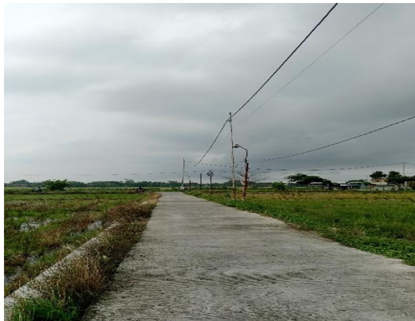
Gambar 26. Kondisi Infrastruktur Jalan Desa Sidorejo
