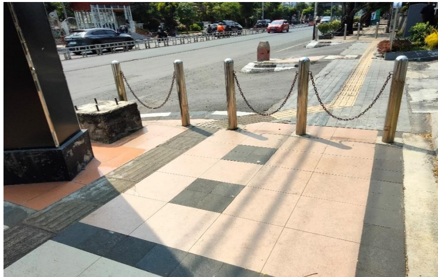
Gambar 21. Jalur Pedestrian Guiding Blocks Dilengkapi Bollard atau Tiang Pembatas
