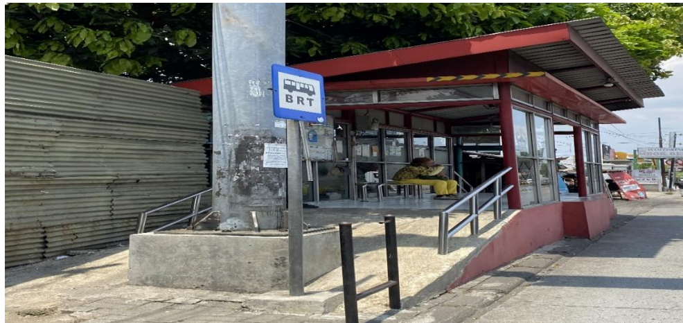
Gambar 11. Halte BRT Tidak Ramah Disabilitas
