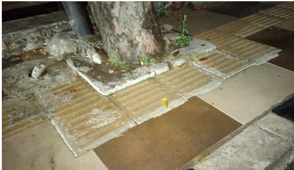
Gambar 19. Perbaikan Jalur Guiding Blocks yang Menabrak Pohon
