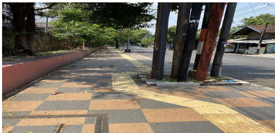
Gambar 20. Perbaikan Jalur Guiding Blocks yang Menabrak Tiang Listrik
