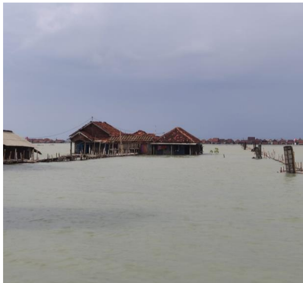
Gambar 5.1 Kondisi Rumah Warga Dukuh Bedono Akibat Abrasi
