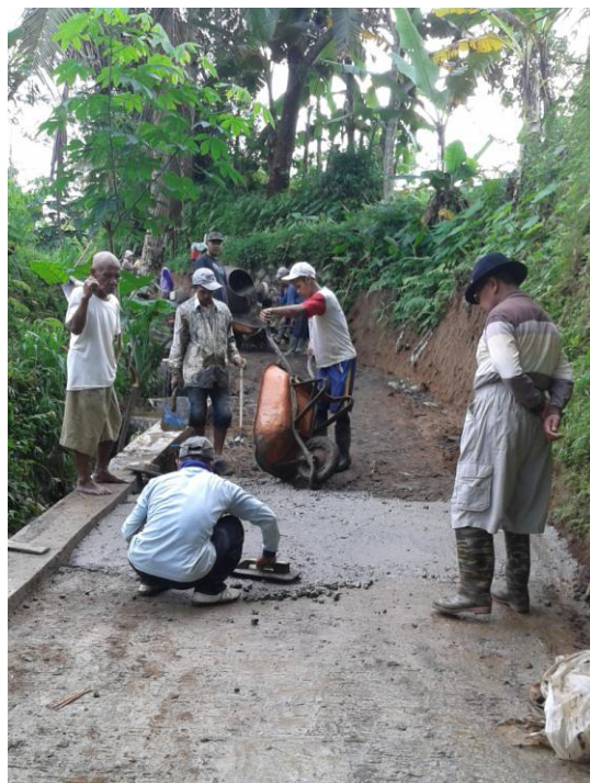
Gambar 7 Gotong Royong Membangun Jalan Akses Persawahan
