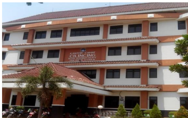
Gambar 5. Kantor Kecamatan Cilincing
