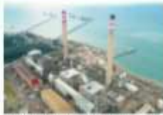
Gambar 38 Batubara sebagai bahan bakar pembangkit listrik Sumber: http://id.shutterstock.com/388389
