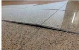
Gambar 16 Pemuaian pada lantai keramik
