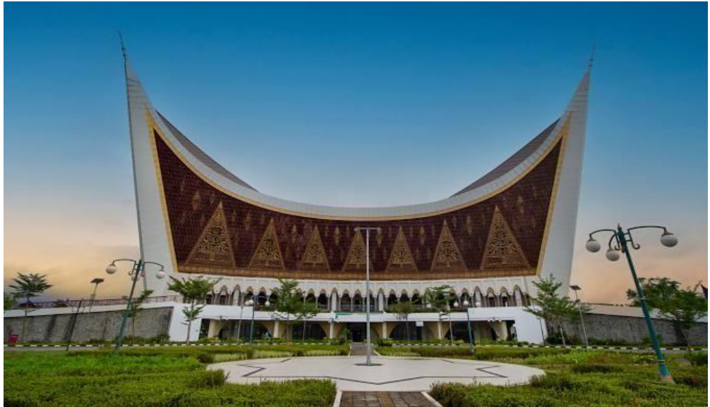
Gambar 2.1 Tampak depan Masjid Raya Sumatera Barat Sumber Gambar: https://padang.go.id/masjid-rayasumatera-barat-3110
