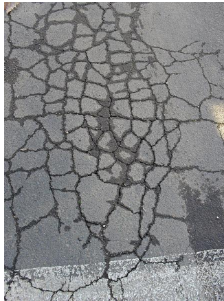
Gambar 2. 2 Retak kulit buaya
