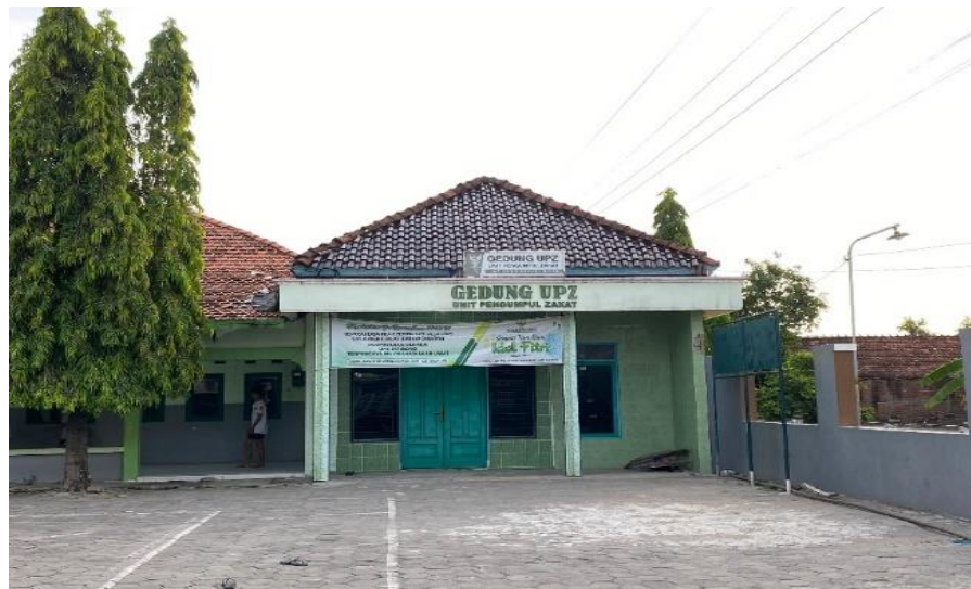
Gambar 3.1 Gedung Upz Desa Jatisono Demak
