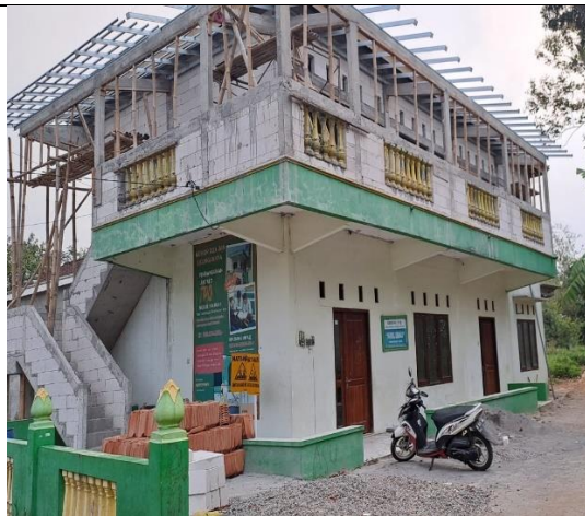
Proses Pembangunan Gedung TPQ Nurul Hikmah
