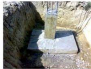
Pondasi Footplat, struktur ini diterapkan pada bangunan bertingkat
