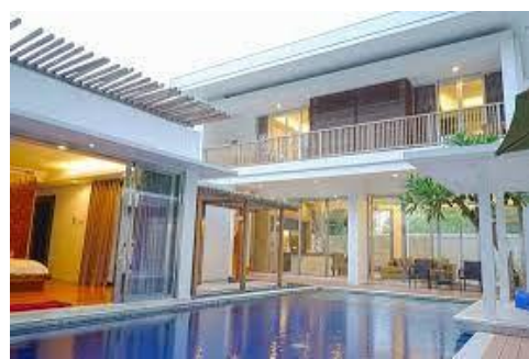
Gambar 2.25 Struktur beton Kharma villas Sumber : https://www.tripadvisor.co.id/
