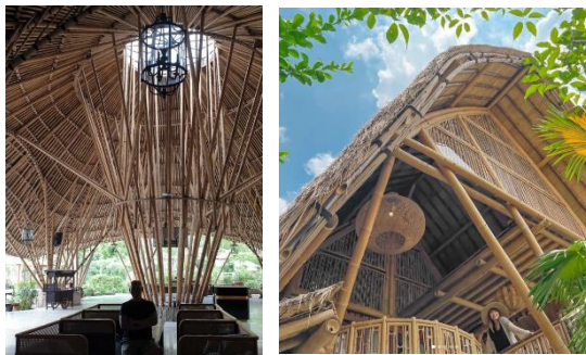
Gambar 2.24 Struktur rangka bambu Kharma villas Sumber : Instagram.com
