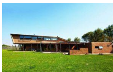
Gambar 2.9 Casa Munita Gonzalez Sumber : pinterest/surtierraarquitectura.cl
