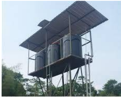
Torn atau tangki air dibuatkan penutup agar terhindar dari sinar matahari langsung
