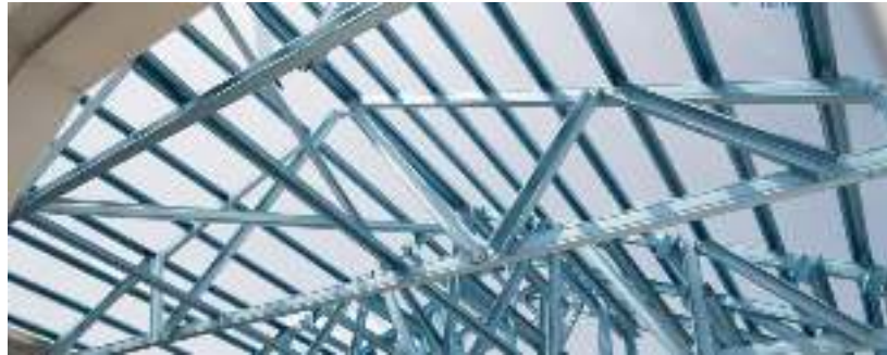
Gambar 26. Struktur atap baja ringan
