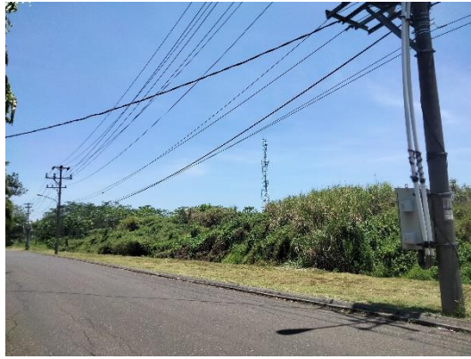
Gambar 4.14 Penerangan Jalan & Drainase
