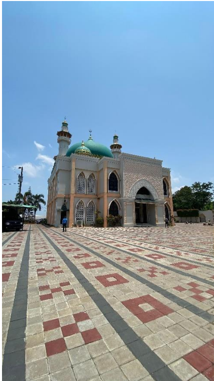
Tampak dari sisi selatan masjid
