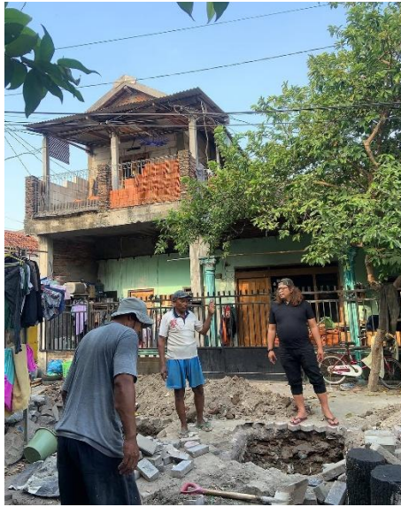
Dokumentasi pembuatan sumur bor Karang Taruna Baskara
