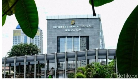
Gambar 6 Gedung Polda Metro Jaya
