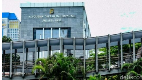
Gambar 2 Gedung Polda Metro Jaya
