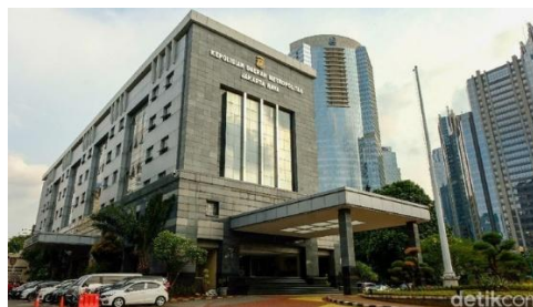
Gambar 5 Gedung Polda Metro Jaya
