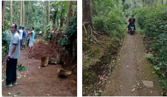
Gambar 10 Pembangunan Jalan Cor
