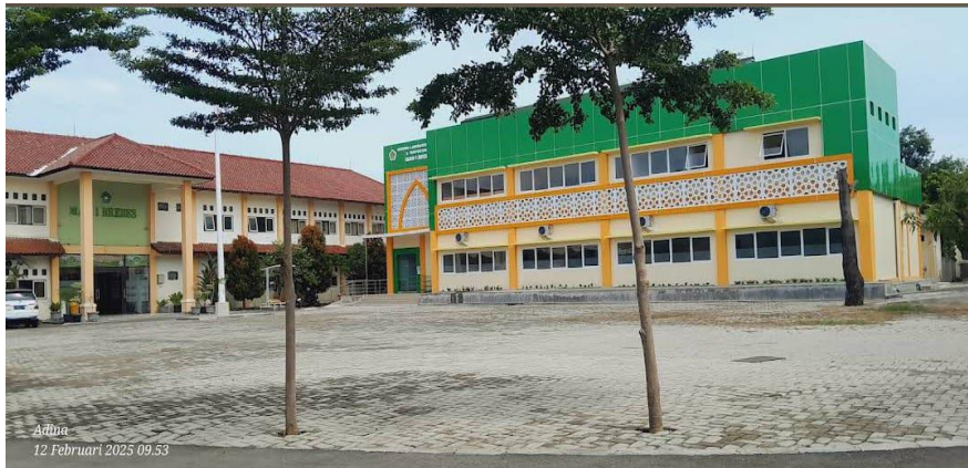
Halaman Depan Gedung Laboratorium baru
