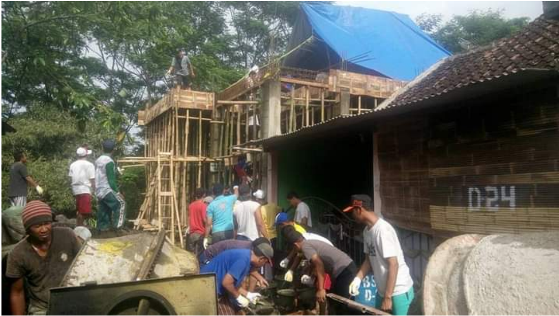
Lampiran 5. Pembangunan TPQ Asy Syuhada tahap 1
